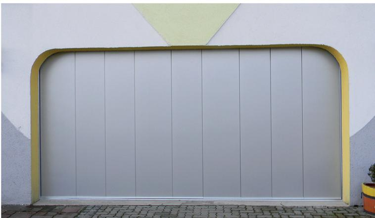
Seitensektionaltore können nach links oder rechts geöffnet und einteilig oder zweiteilig ausgeführt werden. Man kann sie manuell oder - komfortabel - mit Elektroantrieb betätigen.
